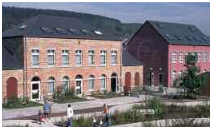
Hébergemnt : le Gîte pour l'Environnement
